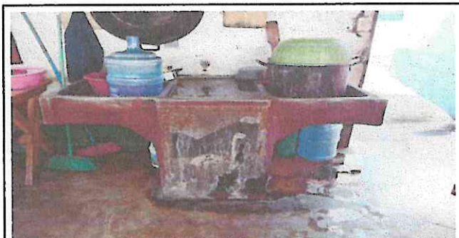
Foto 6: falta de espacio para guardar utensilios
